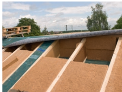
Blick in die Dämmebene der Dachkonstruktion. Vorgeämmte STEICO joist Stegträger mit STEICO flex Dämm-Matten.
